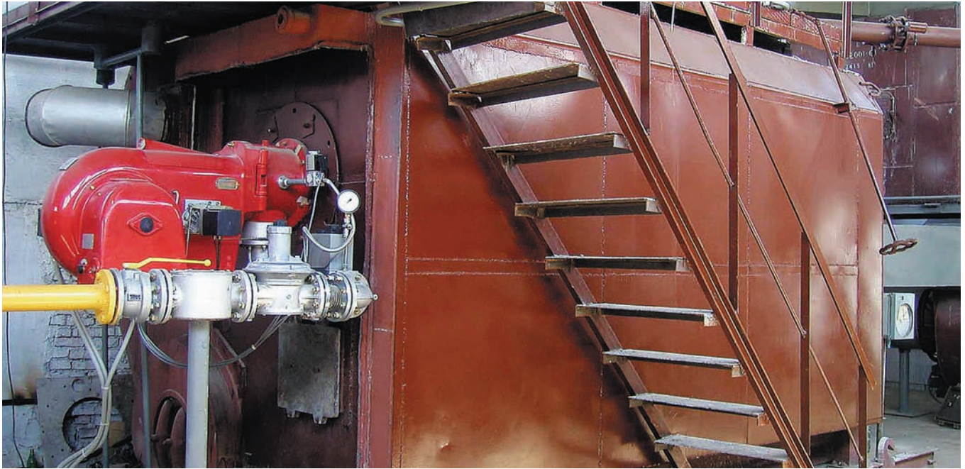
Котел DE-6,5 с адаптированной горелкой G11
