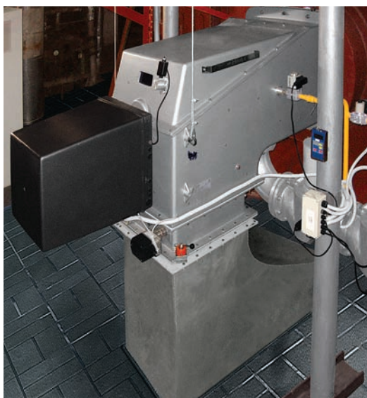
Газовая горелка WKG 80 на котле DE-25
