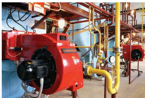
Котлы ДЕ-25 с комбинированными горелками RGL60
