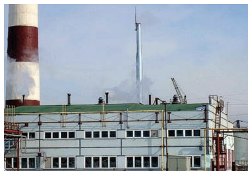
Котельная ООО «АБОЛмед»
