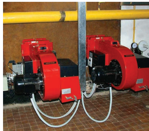
Котел ДКВр-6,5 с горелками Weishaupt КПД котлоагрегата 94,5% NOx – 71,3 мг/м3 (на газе, 100% нагрузка, \alpha = 1 )
