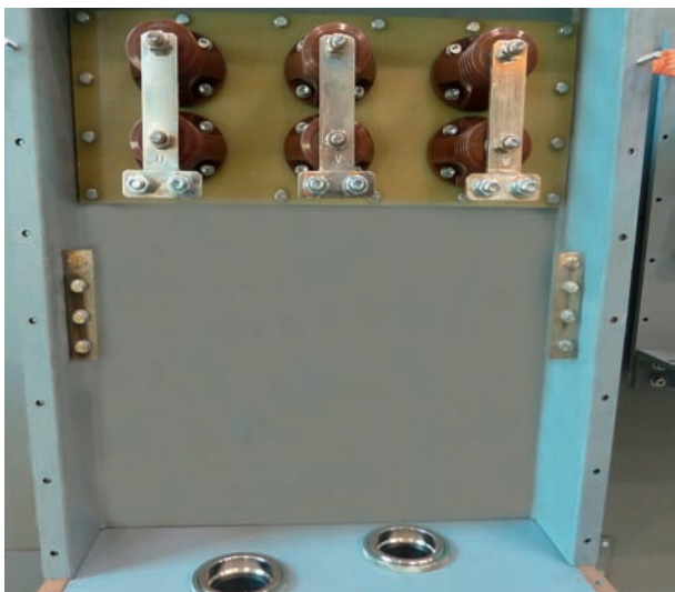
Пример соединительных коробок статора
