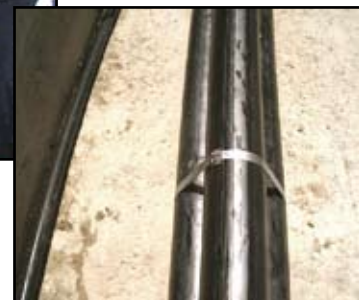
U - Bahn - Verkabelung
