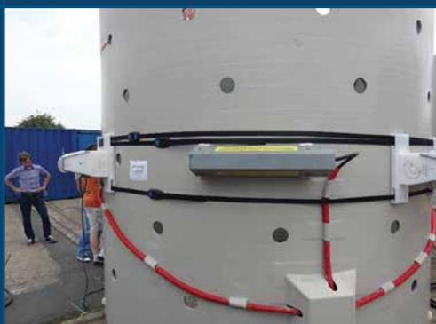
Kabel oder Klammern an den Masten von Windanlagen anzubringen kann teuer und schwierig sein. Die einfache Installation sowie die Korrosionsbeständigkeit macht das Smart® Band auch hier zur idealen Lösung und wurde schon bei vielen Projekten weltweit eingesetzt.
