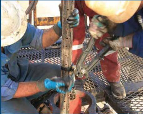
Um das Smart® Band und den Smart® Tie zu installieren hat HCL eine Reihe spezieller Werkzeuge entworfen.
