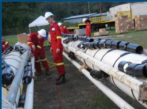
Aufgrund der Elastizität und sehr guten hydrostatischen Kompressionseigenschaften ist das Smart® Band eine hervorragende Einbindemöglichkeit um die Strakes an den Aufstiegsrohren zu befestigen, speziell in der Tiefsee. Die Anfälligkeit gegen zu hohe Einbindekompression ist hier die besondere Herausforderung.
