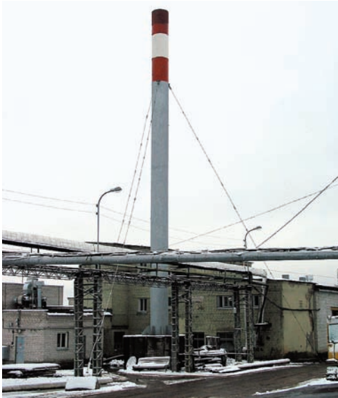
Котельная Кировского молзавода
