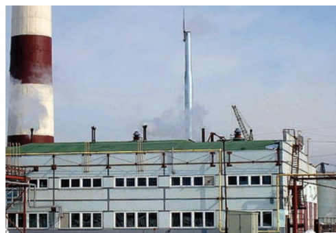
Котельная ООО «АБОЛмед»
