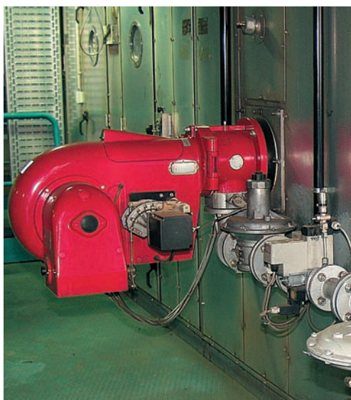
Модулируемая горелка G 7 ZMA с диапазоном регулирования 1:10
