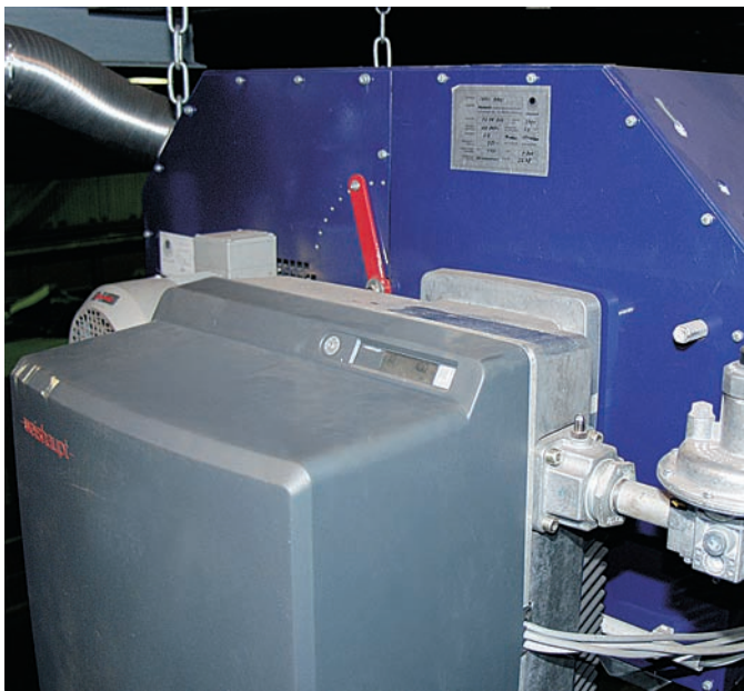
Газовая горелка WG 30 на установке инфракрасного отопления
