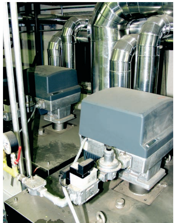
Термомасляные котлы с горелками WG 30
