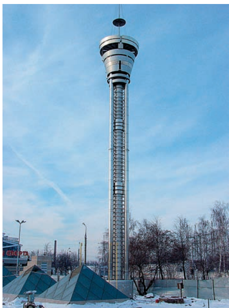
Дымоход и «пирамидки» естественного освещения подземной котельной
