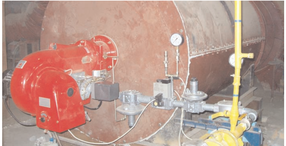
Теплогенератор с газовой горелкой G 7 исп. ZMID
