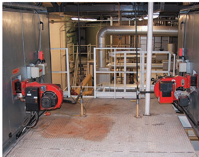
Газовые горелки G 1 в исп. ZMI с диапазоном регулирования 1:20 на климатической установке
